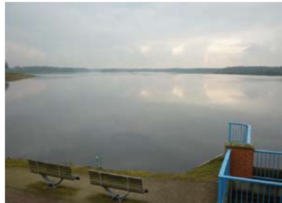
Tülsfelder Talsperre © Foto Grontmij
