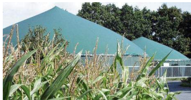
Abbildung 29: Biogasanlage LK Cloppenburg.
