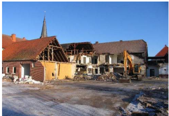
Abbildung 26: Abbruch in Molbergen.
